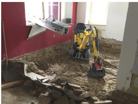
In den einzelnen Räumen wurden die morschen Holzböden entfernt und mit einem Minibagger wird das Erdreich für einen wärmegeprägten Fußbodenaufbau ausgehoben.
