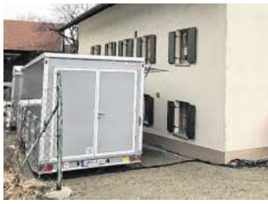
Küche, WC, Duschen und Waschmaschinen sind in separaten Anhängern untergebracht.
